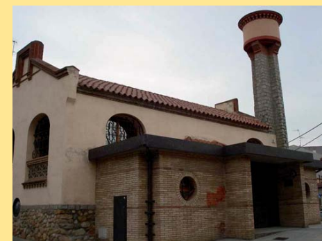
L'arxiu, un dels edificis municipals.
